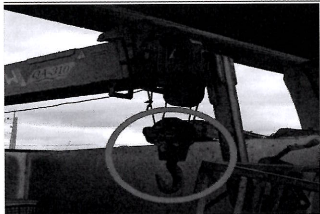
常見缺失樣態-吊鉤未裝防滑舌片
